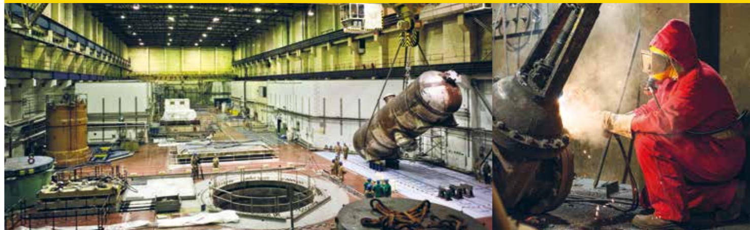
Dekontaminierungsarbeiten in der Reaktorhalle von Greifswald. Rechts im Bild ein Dampf-erzeuger. Bevor er ins Zwischenlager kommt, wird er zersägt.
