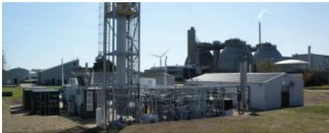
© [www.electrochaea.com](http://www.electrochaea.com) - Electrochaea betreibt bereits eine Power-to-Gas Pilot-Anlage mit einer Leistung von 1 MW in Dänemark. Die neue Anlage in Ungarn soll eine Leistung von 10 MW erreichen. Modell Sterner/Specht 2008.
