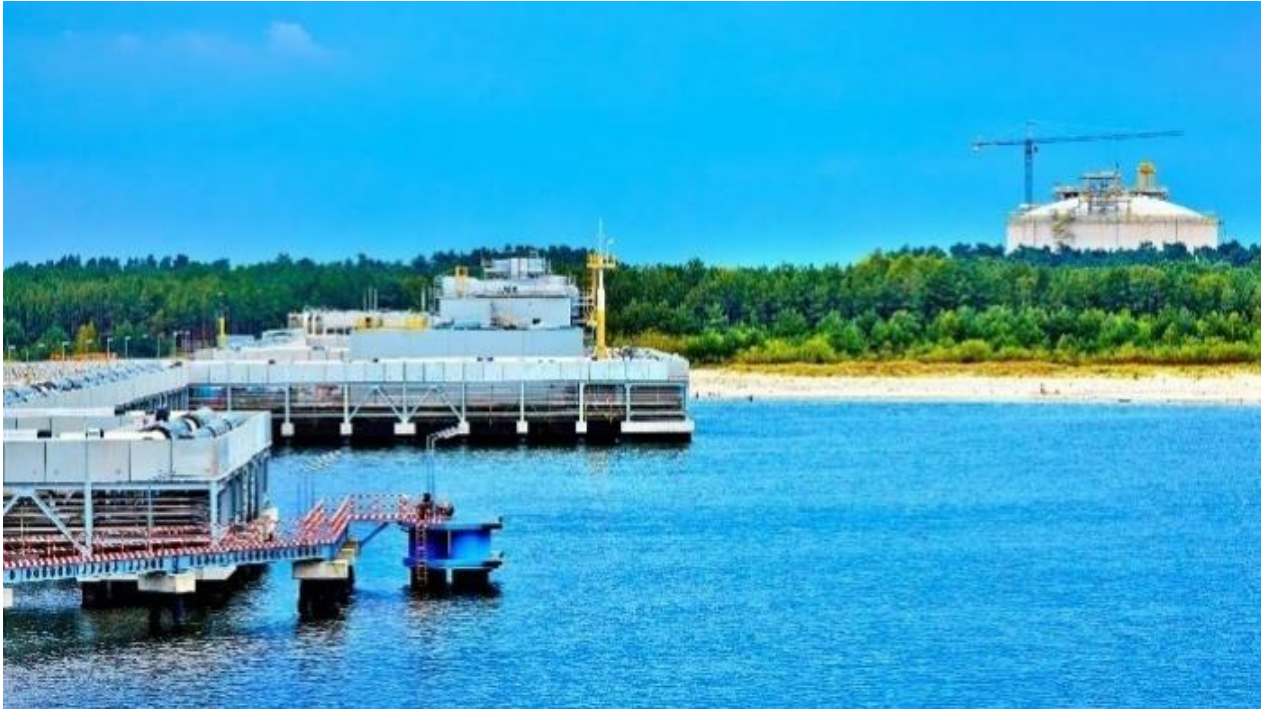
Terminal LNG in Świnoujście, Polen. Bild: Polskie LNG S.A / CC BY-SA 4.0
