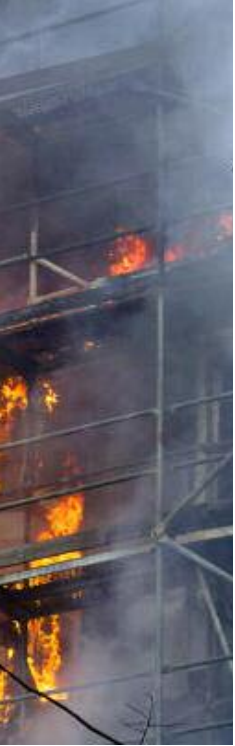
in Frankfurt am Main, Wärmedämmung mit Polystyrol: „Das zündet wie Benzin“
