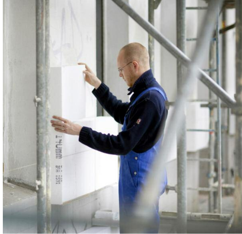
in Frankfurt am Main, Wärmedämmung mit Polystyrol: „Das zündet wie Benzin“
