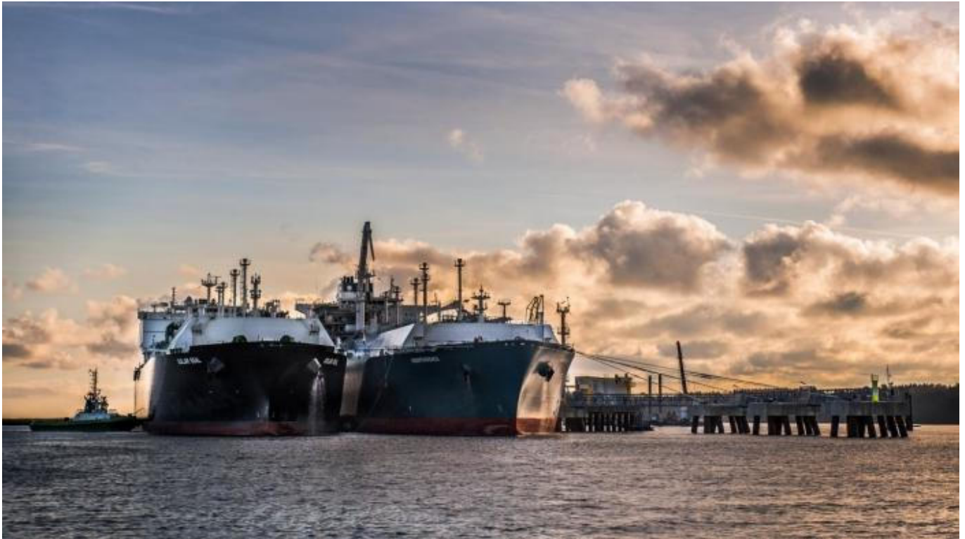
LNG Terminal in Klaipeda. Bild: Klaipedos Nafta
