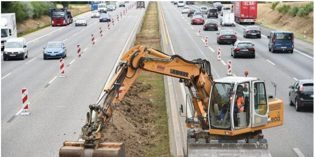
Baggern für die Rente? Baustelle auf der A5 in Hessen. Foto: dpa
