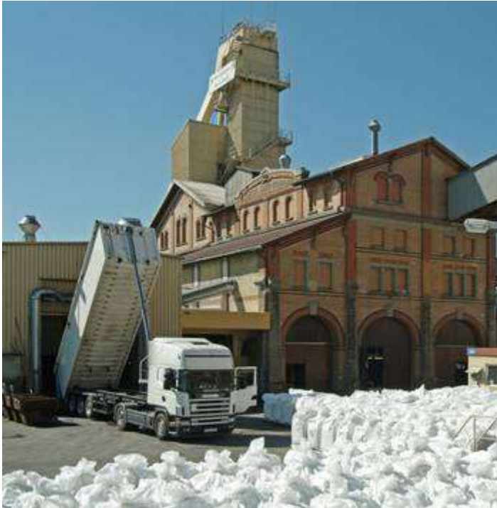
Schacht Heilbronn: Untertagedeponie im Unterland. Foto. SSW AG
